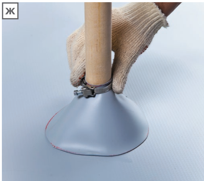
Ж. Вершина конуса обжимается металлическим хомутом.
