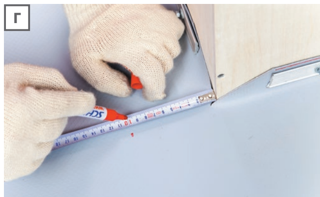
Г. На горизонтальной поверхности кровли на расстоянии 100 мм от стены или парапета наносятся риски.
