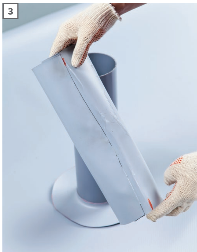
З. И растягивается вручную.
