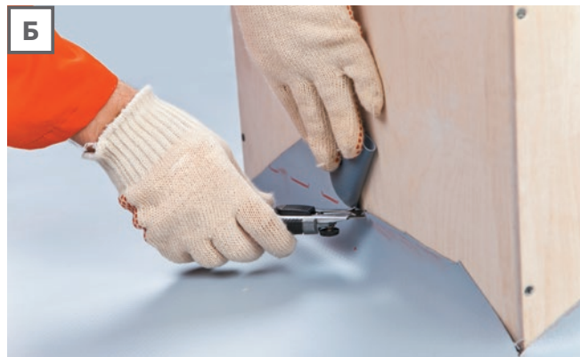
Б. Мембрана заводится с горизонтальной на вертикальную или наклонную поверхность на высоту около 50 мм.
