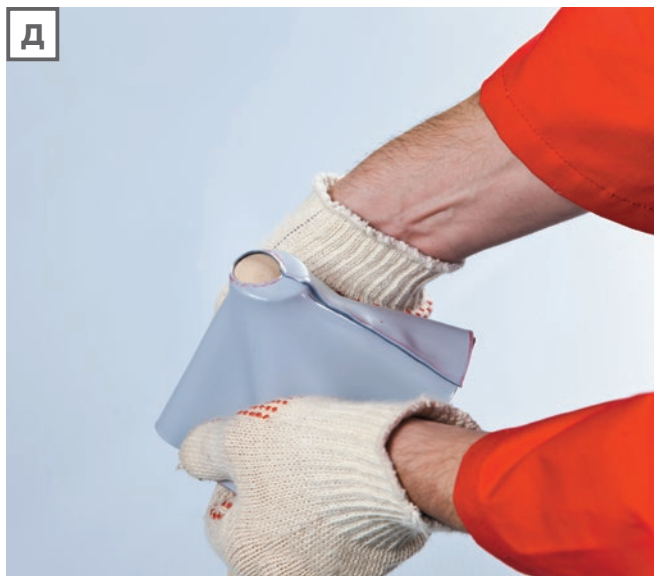
Д. И пока не остыла мембрана натягиваются на изолируемый проход.
