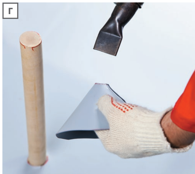
Г. Разогреваются внутренняя и внешняя кромки конуса.
