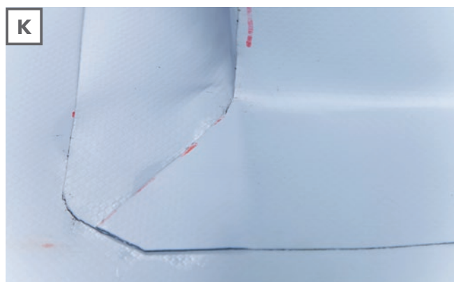
К. Полностью изолированный внешний угол плоской кровли.
