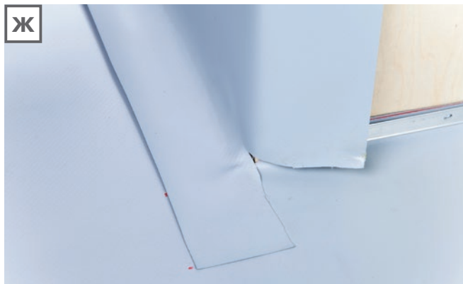
Ж. Затем провариваются вертикальные соединения мембран.
